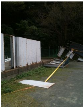
南郷中学校の倒壊したフェールのフェンス
